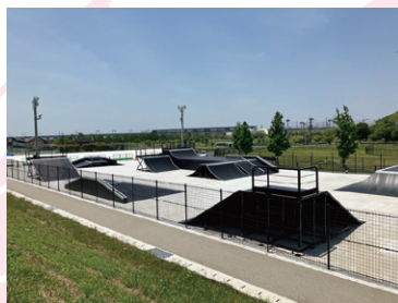
▲今期竣工予定の筑後広域公園内BMXパーク
